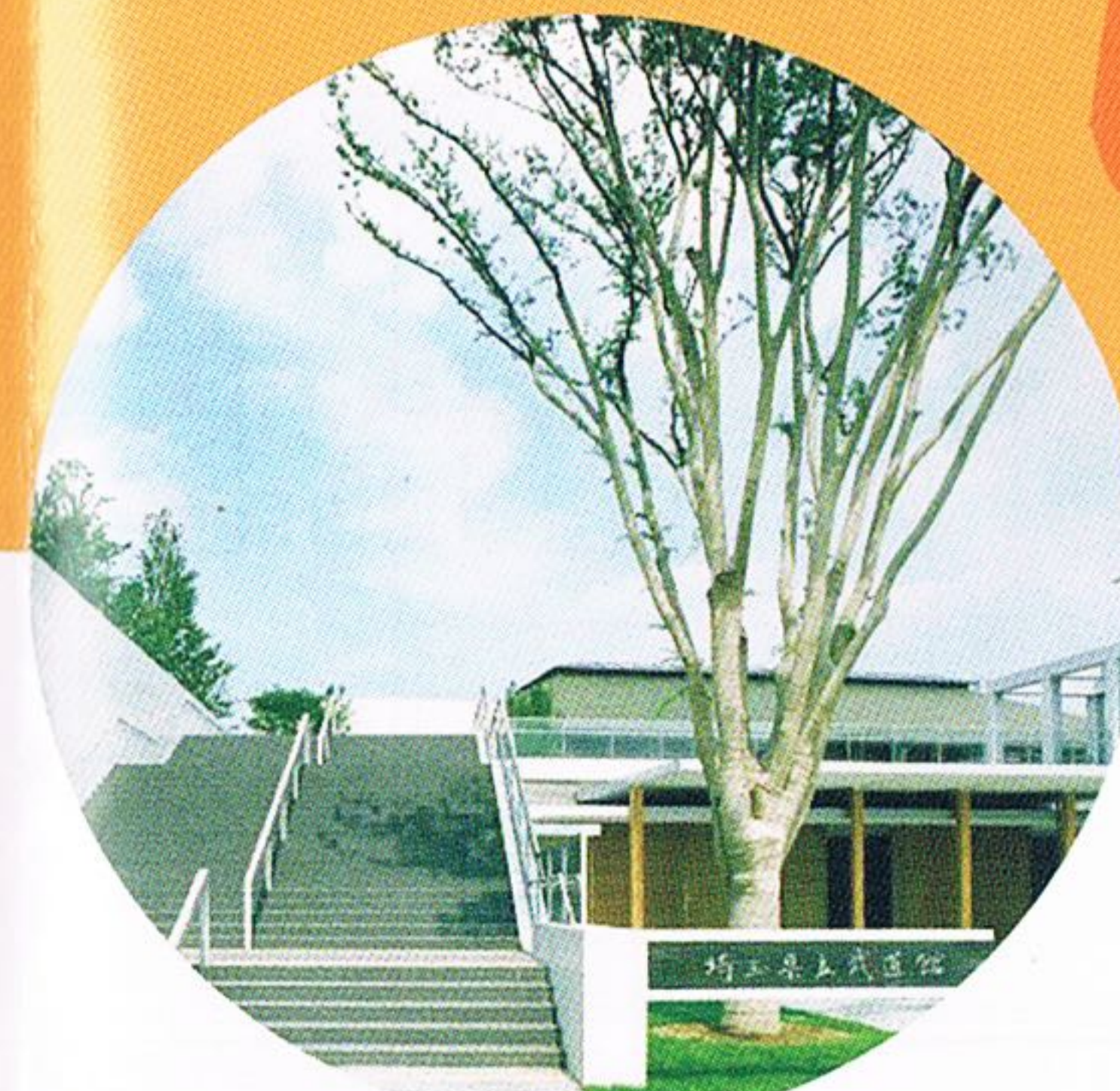
埼玉県立武道館 上尾市日の出4-1877
